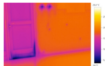
Infiltrations en bas de porte
