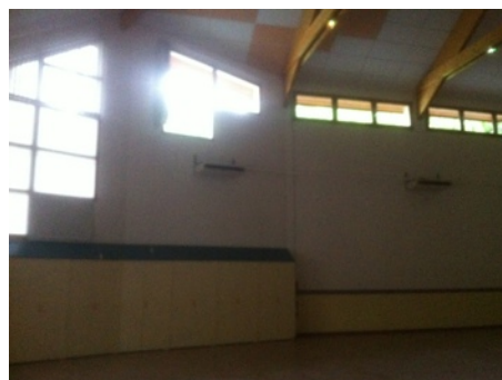
Vitrages hauts de la grande salle
